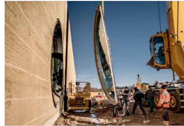
Eines der vier Rundfenster wird eingepasst.
