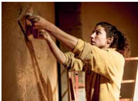
Innen werden die Wände geschlämmt.
