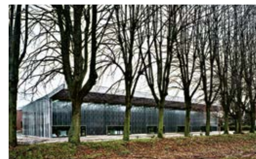
Stirnwände aus Beton mit Regenzeichnung.
